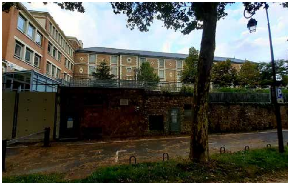
Plaque sur le mur du Lycée La Bruyère
